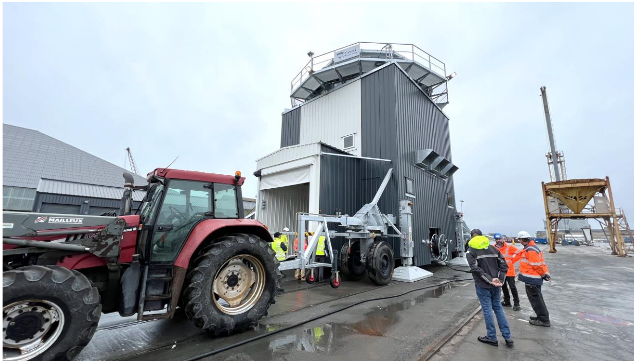
Trémie dépoussiérée en cours de positionnement sur le Quai Chateaubriant
