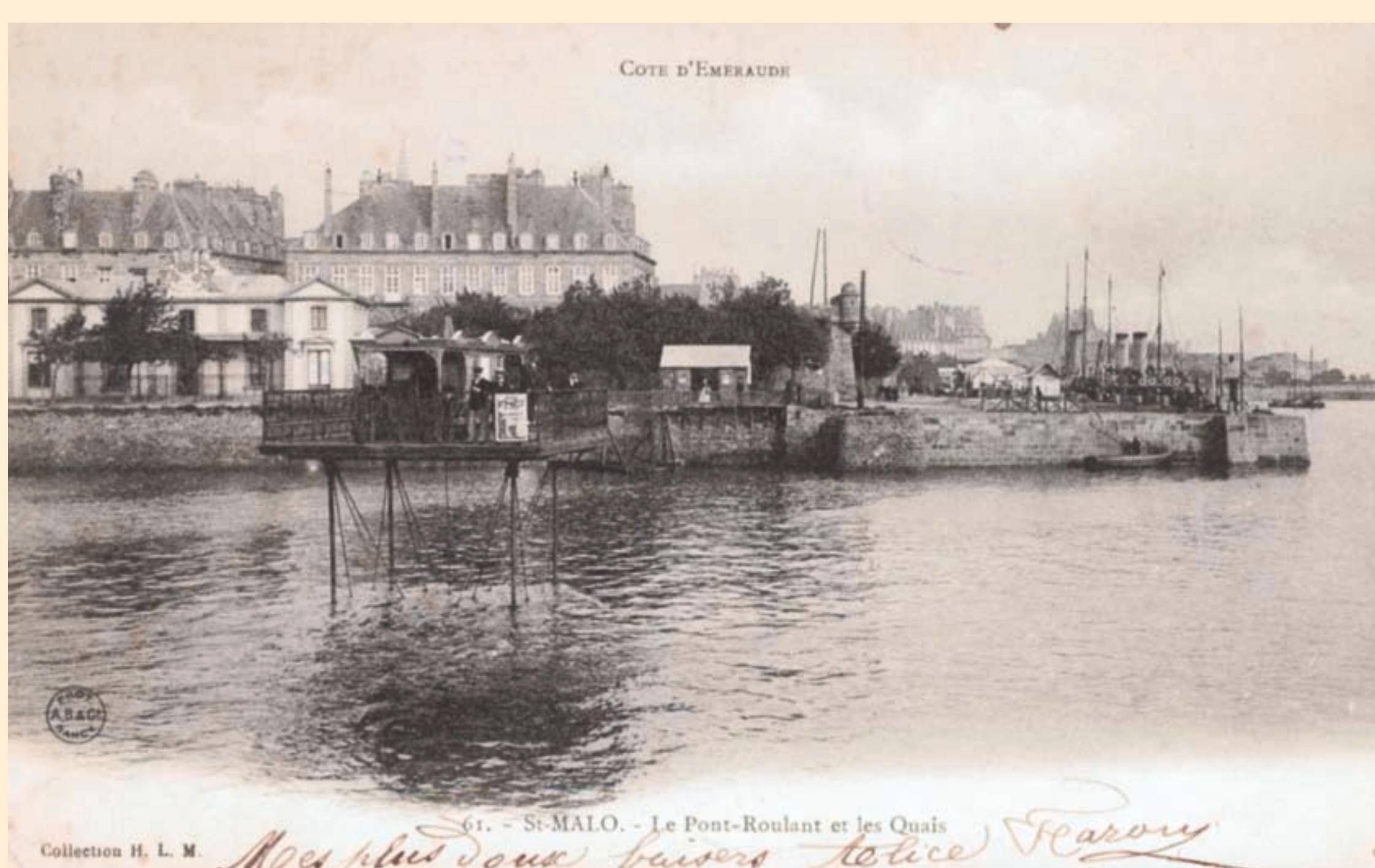
Saint-Malo, le pont-roulant et les quais. Carte postale, éd. HLM, début XX e siècle, AMSM. La bourse de commerce est visible derrière le pont roulant.
