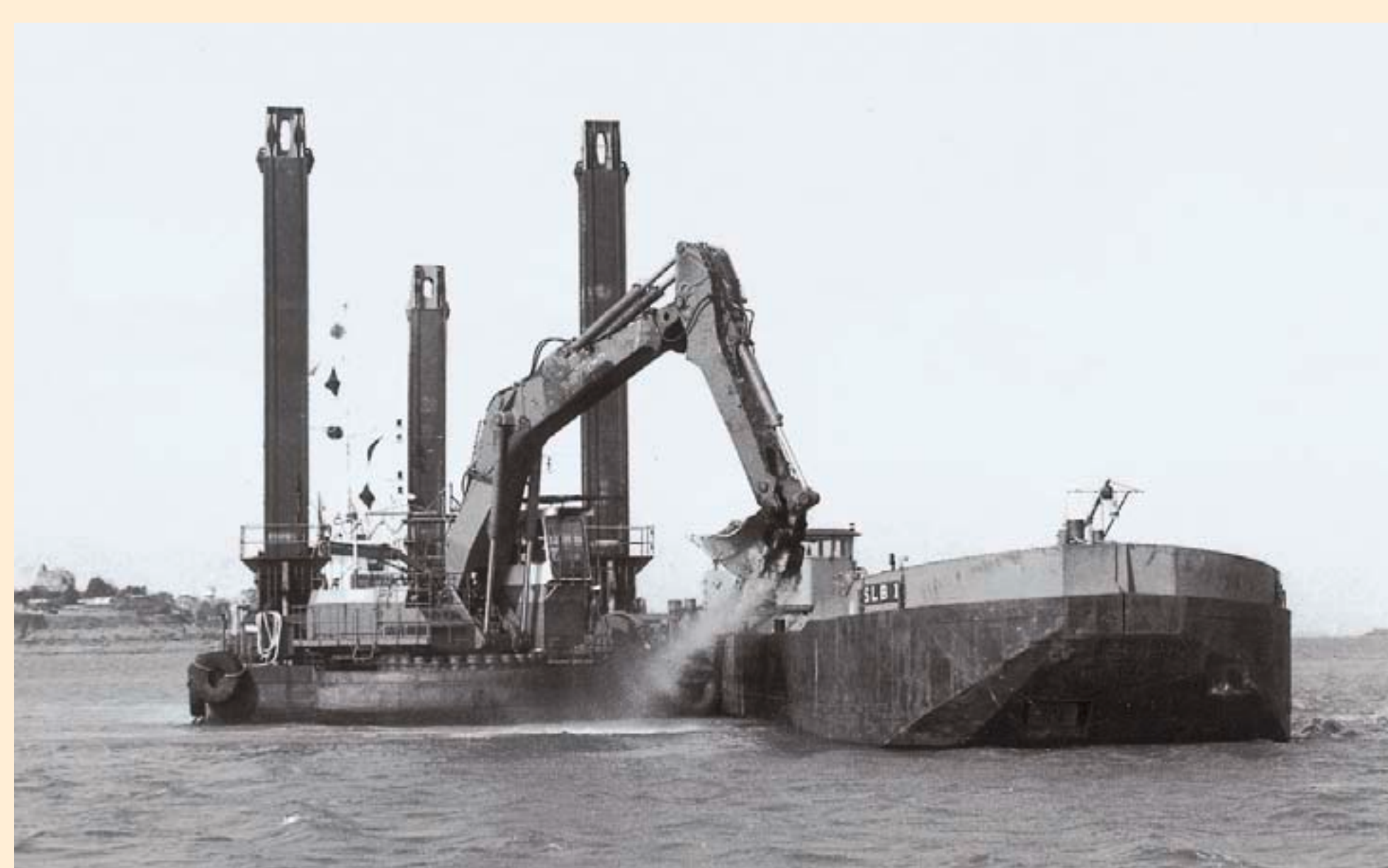
Les travaux de déroctage permettent l'arrivée des ferries de la dernière génération, Collection CCI.
