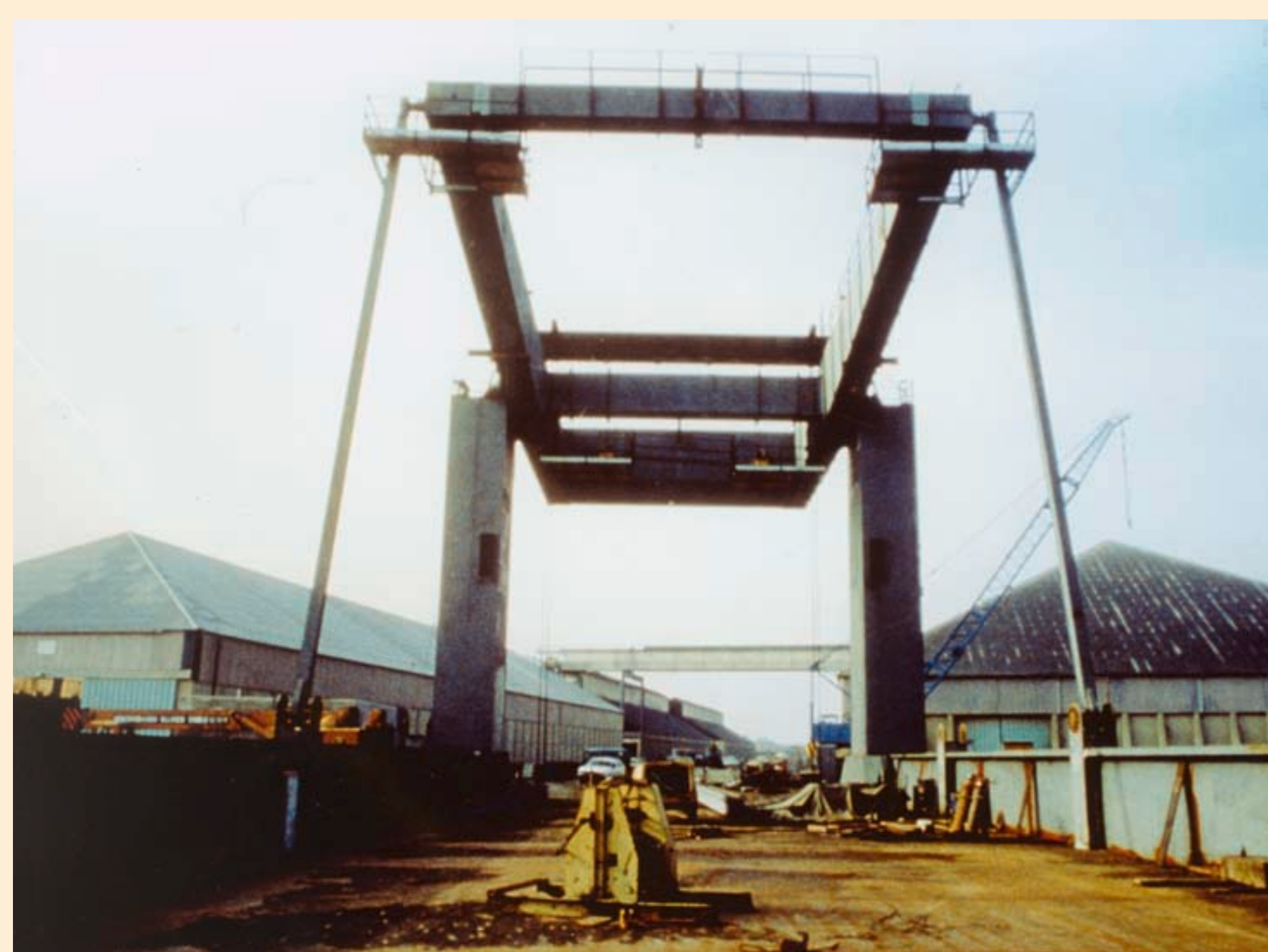
La construction du pertuis avec pont-levis, 1980, Collection CCI.
